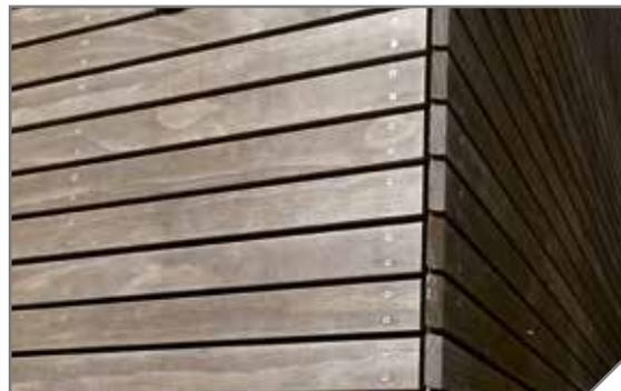
Das Stirnholz der Rhombusprofile ist ungeschützt und kann schneller reißen. Bei modifizierten Hölzern ist das vertretbar, bei stark arbeitenden Hölzern wie Lärche aber nicht zu empfehlen. Es sollte immer geprüft werden, ob für diese Ausführung vom Hersteller eine Stirnholzversiegelung vorgeschrieben ist.
