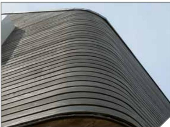
Bei der Farbgestaltung von vorgehängten hinterlüfteten Fassaden kann sowohl mit Holz als auch mit HPL- und Faserzementplatten sowie mit NFC / WPC-Profilen die Optik der Gebäude entsprechend der Kundenwünsche gestaltet werden.
