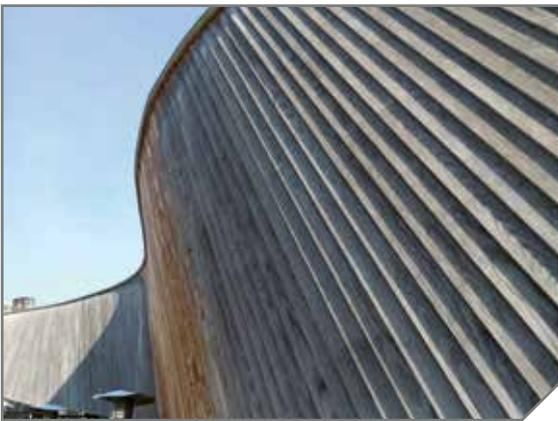
Mit senkrechten Holzprofilen können relativ einfach gerundete Fassaden hergestellt werden. Bei waagerechter Verlegung kann Holz schnell an seine Grenzen kommen.
