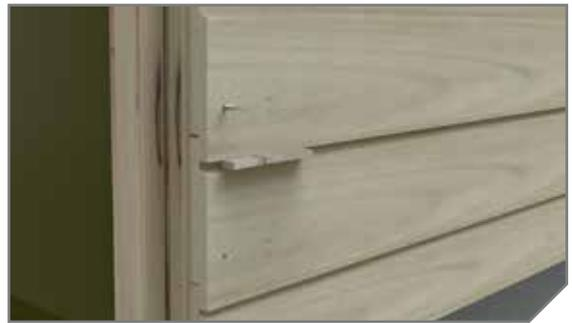
Die Befestigung soll entweder im untersten Drittel der Fläche oder schräg durch den Federbereich erfolgen.
