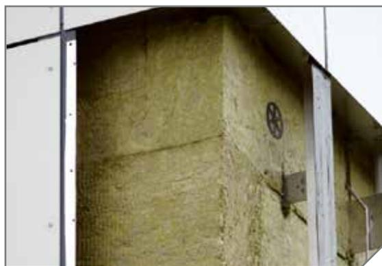
*Mineralwolle wird oftmals bei großen Gebäuden aufgrund der Einstufung in die Baustoffklasse A1 / nicht brennbar, verwendet.*
