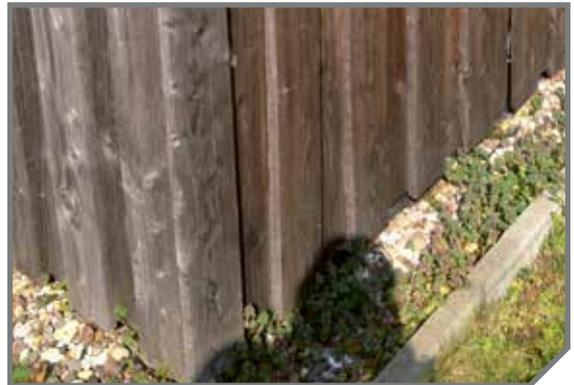
*Kiesstreifen ist zugewachsen und dadurch ist kein ausreichender Spritzwasserschutz mehr gegeben.*
