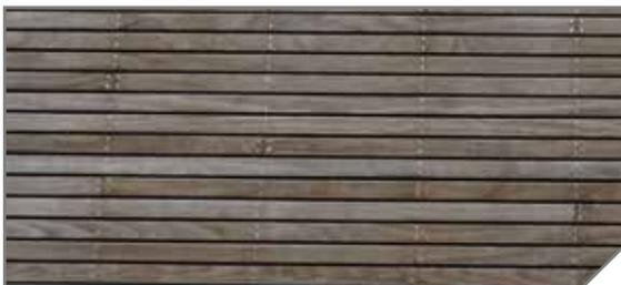
Fassadenbahnen können diesen Schutz je nach Hersteller und Produkt zuverlässig sicherstellen. Dabei muss berücksichtigt werden, dass die Produktauswahl von der geplanten Fugenbreite und dem Anteil der Fuge an der Gesamtfläche der Fassade abhängt. Fassadenbahnen müssen zusätzlich diffusionsoffen, UV-beständig und reißfest sein.
