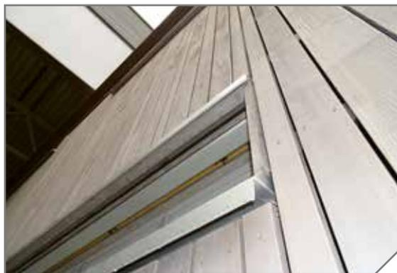
Bei offenen Fassadenbekleidungen können Kleintiere wie z. B. Mäuse auch bei der Verwendung von Schutzgittern im Fensterbereich oder im Sockel- oder Dachbereich durch die Fugen der Bekleidung eindringen. Es sollte dann unbedingt auf eine geeignete Wärmedämmung geachtet werden.
