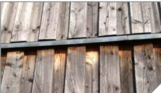
Als alternative Ausführung darf bei durchgehenden horizontalen Geschoßfugen die Bekleidung mit mindestens 5 mm Fugenabstand und 15° Grad Hinterschneidung ausgeführt werden.
