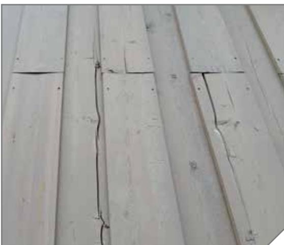
Wenn durch das Deckbrett direkt das Bodenbrett mit verschraubt wird, werden beim Arbeiten der Hölzer starke Risse auftreten.
