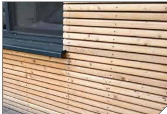
Für eine funktionierende Konstruktion müssen die Bekleidungs Bretter waagrecht und nicht senkrecht montiert werden und eine regelmäßige Reinigung des Kiesstreifens ist erforderlich.
