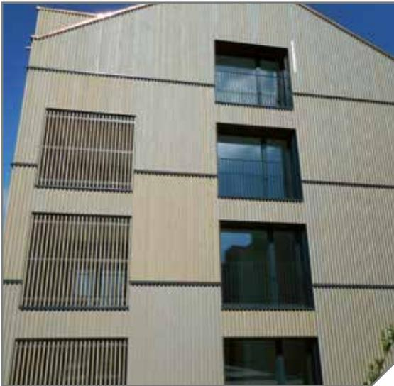
Wenn farbig behandelte Fassadenbekleidungen aus Holz oder auch bei farbigen Faserzementprodukten und HPL-Platten für Großprojekte geliefert werden, sollte auf mögliche Farbunterschiede bei verschiedenen Chargen hingewiesen werden. Bei der Montage sollte dann nur Produkte aus einer Charge zusammen verlegt werden. Die Unterschiede an der Fassade fallen auf und gleichen sich teilweise nicht an.
