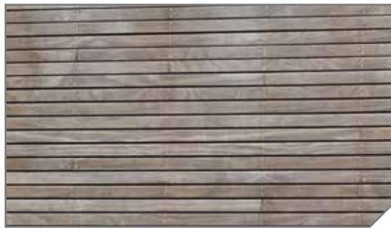
Wenn Fassadenprofile in der Länge auf einer Unterkonstruktion gestoßen werden müssen, ist eine Abweichung nicht zu vermeiden. Die Verschraubung an den Stoßfugen muss gleichmäßig erfolgen.
