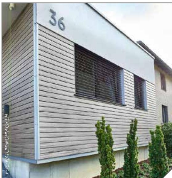
Die Zusammensetzung von WPC-Produkten ist sehr unterschiedlich. Als Hauptbestandteil werden zu 50% bis 75% Fasern aus Holz / Bambus / Reis oder Zellulose verwendet. Bei den verwendeten Kunststoffen wird PP = Polypropylen, PE = Polyethylen oder PVC = Polyvinylchlorid verwendet. Der Polymeranteil liegt bei den Produkten zwischen 25% und 50%. Je höher der Kunststoffanteil, desto höher sind auch die Ausdehnungswerte bei Temperaturveränderungen.
