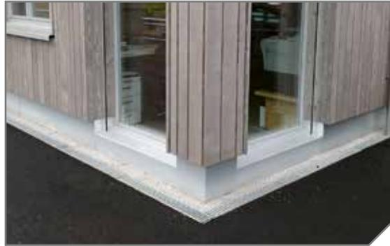
Bei einer flächigen Brettverkleidung sollte die Einteilung der Bretter optimal auf die Gebäudeecken abgestimmt werden. Es sind meistens keine zusätzlichen Produkte erforderlich.
