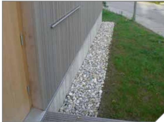
Bei waagrecht verbauten Bekleidungs Brettern aus Holz können die untersten Profile als Verschleißteil dienen und sollten daher leicht austauschbar sein. Bei der Beratung sollte mit dem Kunden die genaue Ausführung besprochen werden und auch welche optischen Beeinträchtigungen bei einem Austausch der Profile auftreten können. Auch die Haftungsfreistellung sollte mit den notwendigen Erklärungen und Pflichten ausgestellt werden.
