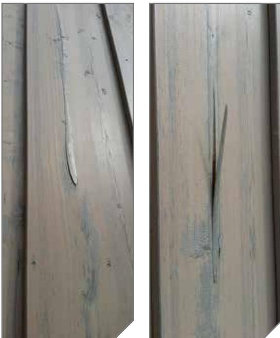
Bei Fassadenprofilen kann es durch die Bewitterung und durch das Arbeiten des Holzes zu einer sogenannten Ringschale kommen. Diese Risse entlang von Jahresringen lassen sich kaum vermeiden.
