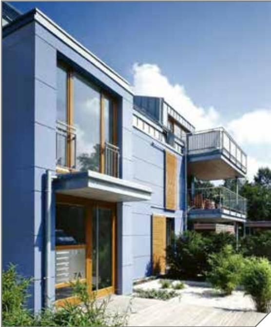
Die Fassade eines Gebäudes kann durch unterschiedliche Plattengrößen sowie durch Farben und Dekore sehr variabel und interessant gestaltet werden. Auch die Kombination mit anderen Materialien wie Glas, Stein und Holz unterstreicht die Vielfältigkeit der HPL-Produkte.
