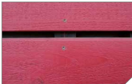
Spaltung der Unterkonstruktion durch die Schraube
