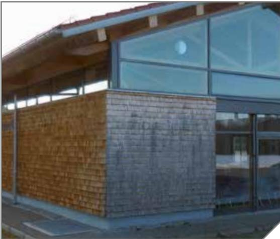
Es werden sowohl heimische Holzarten als auch hochwertige Schindeln aus nordamerikanischen Hölzern für Fassaden verwendet. Gebräuchliche Schindelformen für die Fassade sind keilförmig gespaltene oder gesägte Schindeln und gleich dicke gespaltene oder gesägte Schindeln. Es gibt weiterhin noch Zierschindeln, die mit verschiedenen Rundungen oder Verzierungen versehen sind.
