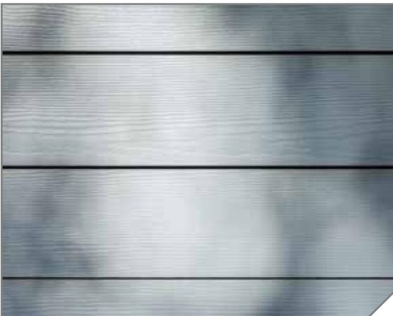
Faserzementplatten werden häufig bei größeren Gebäuden eingesetzt. Die Verwendung von großformatigen Platten bei vorgehängten hinterlüfteten Fassaden reduziert den Montageaufwand, da bei guter Planung ein hoher Vorfertigungsgrad in der Werkstatt möglich ist.
