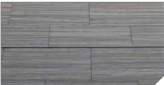
Holzverkleidungen können z. B. in der Werkstatt als Elemente vorgefertigt und dadurch die Montagezeiten und auch die gesamte Bauzeit reduziert werden.
