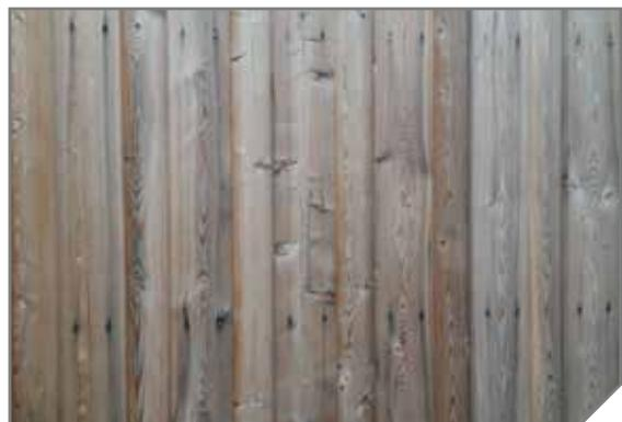
Die metallischen Anteile der Befestigungsmittel können in Verbindung mit der Gerbsäure der Hölzer Verfärbungen auf der Oberfläche verursachen, die nur schwer zu beseitigen sind und oftmals ein Austauschen der Profile erforderlich macht. Bei einigen modifizierten Materialien sind teilweise A4-Schrauben erforderlich.
