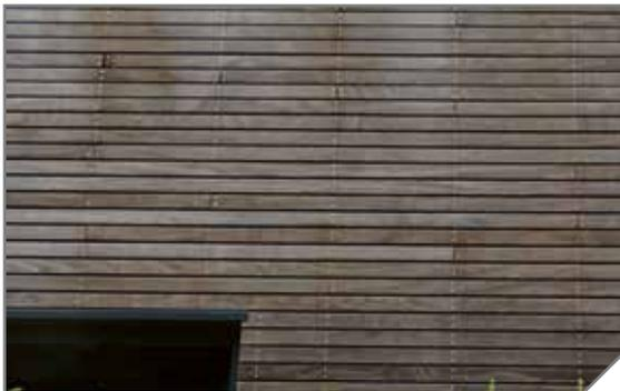
Alle Profile einer vorgehängten hinterlüfteten Fassade aus Vollholz müssen entsprechende CE-Kennzeichnungen am Produkt oder auf den Begleitpapieren haben. Zudem müssen die Vorgaben der Bauproduktverordnung eingehalten werden.
