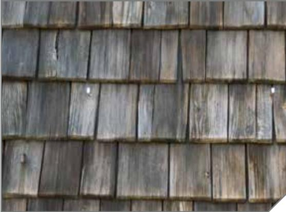
Die Vergrauung hat keinen Einfluss auf die Funktionalität und Stabilität der Fassade. Eine mehrjährige Bewitterung kann zu einer Erosion der Oberfläche führen und bis zu 3 mm betragen.
