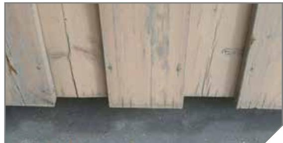
Je nach Beschichtungssystem ist die Oberfläche nur für einen bestimmten Zeitraum haltbar und muss nachbehandelt werden. Mit dem Bauherrn sollte schon bei der Auftragsvergabe über die erforderlichen Wartungsarbeiten und Intervalle nach Herstellerangaben gesprochen werden. Der Abschluss eines Wartungsvertrages ist zu empfehlen.
