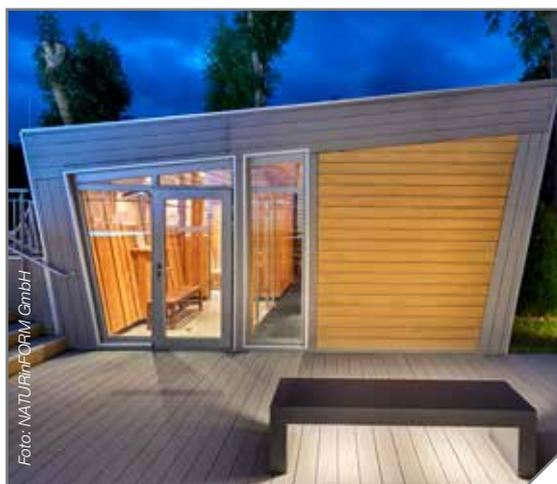
WPC-Produkte werden durch thermoplastische Formgebungsverfahren wie Extrusion, Spritzguss oder Presstechniken hergestellt. Bei Fassadenprofilen werden in einem mehrstufigen Prozess die Fasern mit dem Kunststoff und den Additiven vermischt. Unter hohem Druck und Wärme wird das Gemisch in einem Extruder durch entsprechende formgebende Werkzeuge gepresst und erhält durch die anschließende Abkühlung seine Form. Je nach Hersteller und Produkt werden die Profile nach der Abkühlung in einem
