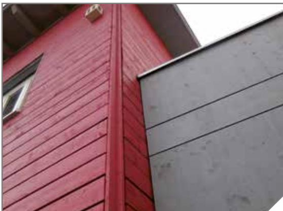
Bei der Gestaltung von Fassaden können Massivholzprofile und Platten sehr gut kombiniert werden. Auch unterschiedliche Farben werden für die Gestaltung gewählt.
