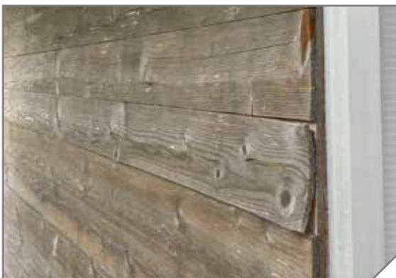
Bei der Nichtbeachtung der Herstellerangaben und bei mangelhafter Wartung und Pflege können Delaminierungen und Beschichtungsschäden auftreten.
