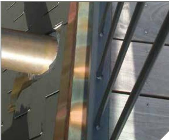
*Oberflächenwasser führt in Verbindung mit den Holzinhaltstoffen zur Verfärbung des Kupferblechs.*
