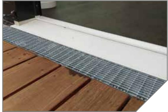
*Eine Türschwelle mit max. 2 cm Höhe und zusätzlicher Entwässerungsrinne erfüllt die Vorgaben für die Barrierefreiheit.*
