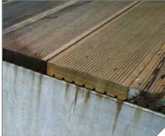
*Auswaschungen aus Bangkirai, die sich nur durch eine konstruktive Lösung verhindern lassen.*
