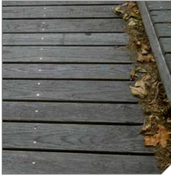
*Laub und Schmutz muss aus den Fugen entfernt werden, damit keine Pilze entstehen können.*
