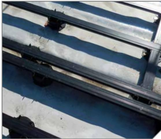
*Aluminiumunterkonstruktion werden oftmals mit Verstellfüßen als System angeboten und müssen nur eingeklickt werden.*
