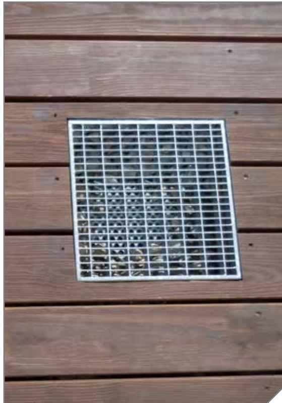
Für Wartungsarbeiten muss die Entwässerung immer zugänglich sein. Mit Entwässerungsrosten ist das einfach möglich.
