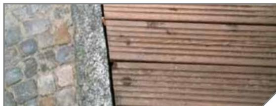
Bei Terrassen, die ebenerdig erstellt werden, sollten dauerhafte Holzarten eingesetzt werden.
