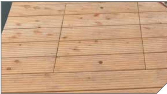
Bei Revisionsklappen aus Holz muss der bauliche Holzschutz beachtet werden.
