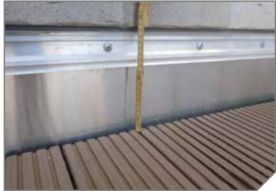
*Die Abdichtung sollte am Gebäude min. 150 mm über die Oberfläche der Terrasse geführt werden und ist z.B. mit Verbundblechen oder Klemmprofilen zu sichern.*
