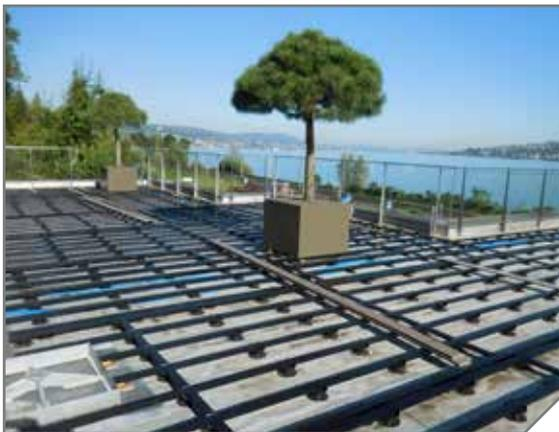
*Aluminiumunterkonstruktion mit Stelzlagern und Verstellfüßen*
