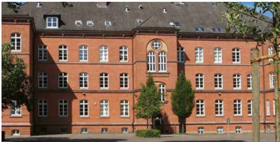
Abb. 1 Typische Fassade mit Verblendmauerwerk (Baujahr 1892)
