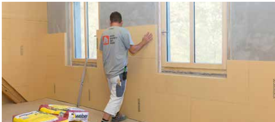
Großes Plus in der Verarbeitung: Die Holzfaserdämmplatte Thermoroom wird nicht mechanisch befestigt, sondern mit Klebe- und Spachtelputz auf den Untergrund geklebt – und das witterungsunabhängig über das gesamte Jahr. Foto: GUTEX
