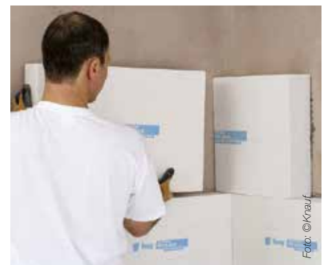
Abb. 5 Die mineralischen Dämmplatten werden mit einem kapillaraktiven Mörtel im Vollkontakt mit dem vorhandenen Innenputz montiert.
