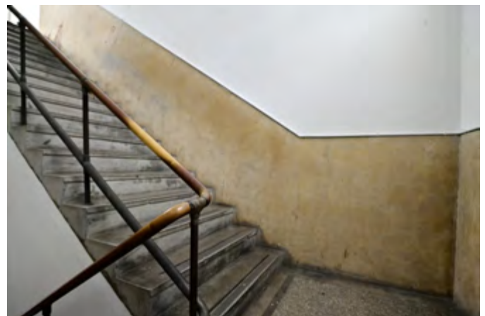
Treppensanierung als Herausforderung: Terrazzo, Stahlbau und Treppengeländer aus Holz und Anforderungen aus der Treppenbaunorm
