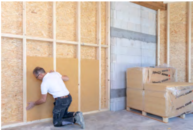
Außenwanddämmung mit Vorsatzschale
