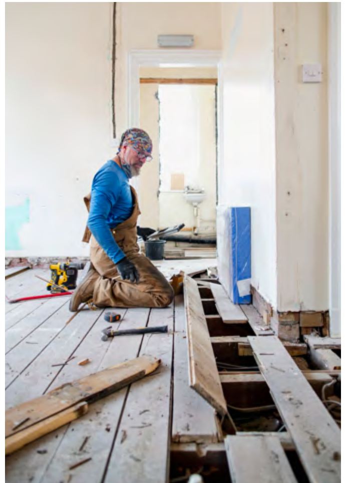
Neuer Bodenaufbau auf Holzbalkendecke
