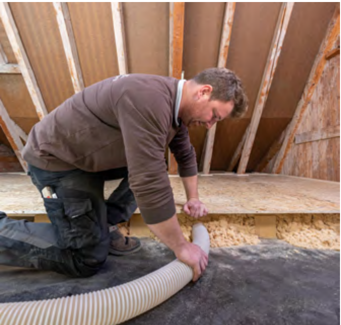
Begehbare Geschossdecke mit Holzfaserdämmung
