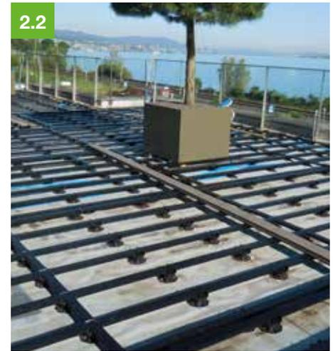
Für Aluminiumprofile gibt es auch entsprechende Längs- und Eckverbinder, die besonders bei großen Flächen die Montagezeit reduzieren
