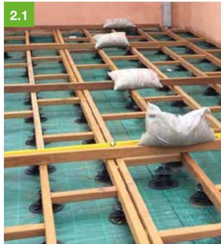
Eine ausgesteifte Rahmenkonstruktion ist optimal für den Höhenausgleich mit Verstellfüßen geeignet.
