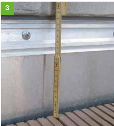
Die Bauwerksabdichtung muss bei allen Terrassenbelägen mindestens 150 mm über die Oberfläche des Belags geführt werden und z. B. mit Klemmprofilen gesichert sein.
