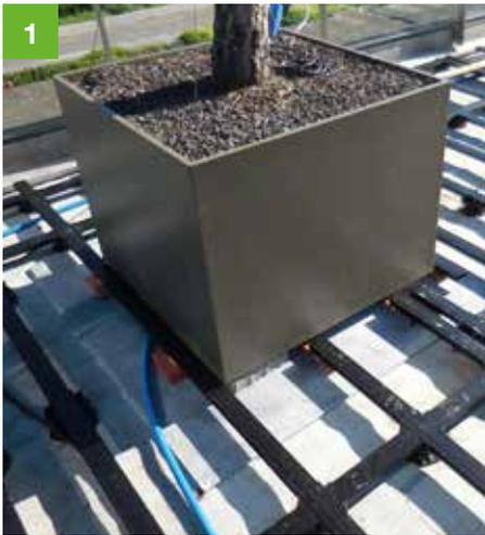
Bei schweren Blumenkübeln kann mit untergelegten Stahlplatten eine gleichmäßige Belastung der Dachkonstruktion, insbesondere der Dämmung, ermöglicht werden.
