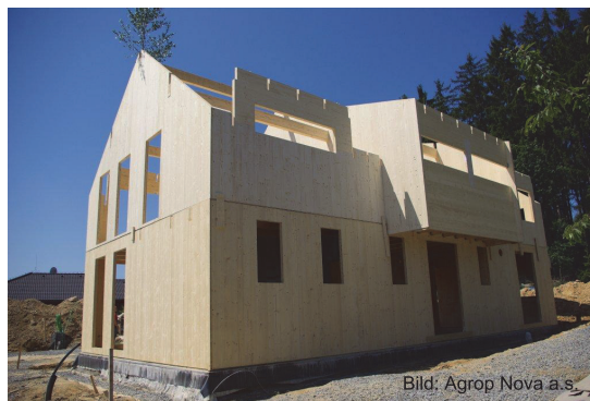
Abb. 84: Rohbau im Holzmassivbau mit Brettsperrholzelementen. Es sind alle individuellen Gebäudeformen erstellbar.
