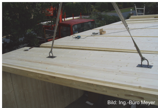
Abb. 84: Rohbau im Holzmassivbau mit Brettsperrholzelementen. Es sind alle individuellen Gebäudeformen erstellbar.
