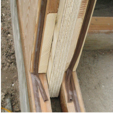
Abb. 87: Die Fremdfeder stellt sowohl die Verbindung zwischen den Elementen, wie auch die Verbindung zur Schwelle her. In der Schwelle wird dazu ein Zapfenloch hergestellt.
