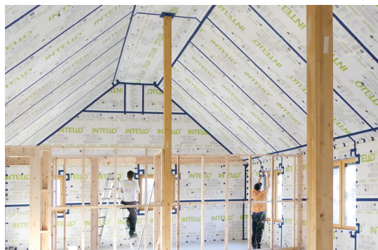
Abb. 7: Messzeitpunkt: Nach Fertigstellung der Luftdichtheitsebene im Zuge der Gewerkeabnahme. Bild: Moll pro clima
