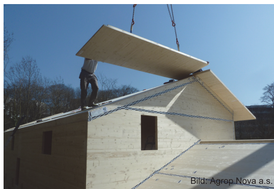
Abb. 85: Selbst Dächer können hergestellt werden.
