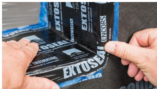
Abb. 52: Eine zweite wasserführende Ebene unterhalb der Fensterbank schützt die Wandkonstruktion vor schädlichem Wassereintrag (siehe H • 6 • g).
