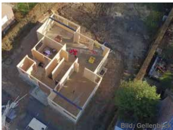
Abb. 7 Bautenstand am Morgen, die EG-Wände sind montiert.
