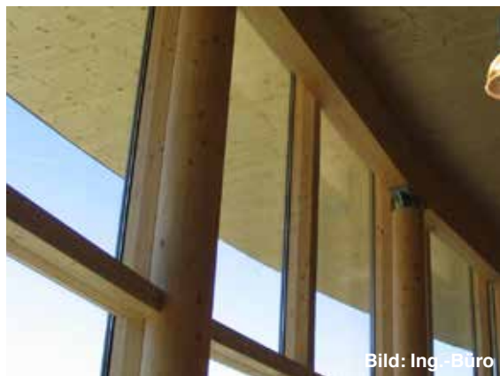
Abb. 47 Bei dieser Ausstellungshalle mit Brettsperrholzelementen wurde ein Dachüberstand von ca. 3 Metern Auskragung hergestellt. Der Konstruktionsaufbau ist einfach.
