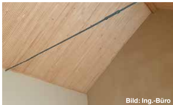
Abb. 13 Hier ist eine Dachuntersicht aus klassischen Brettstapелеlementen zu sehen. Die Fugen sind betont ausgeführt und systemtypisch.
