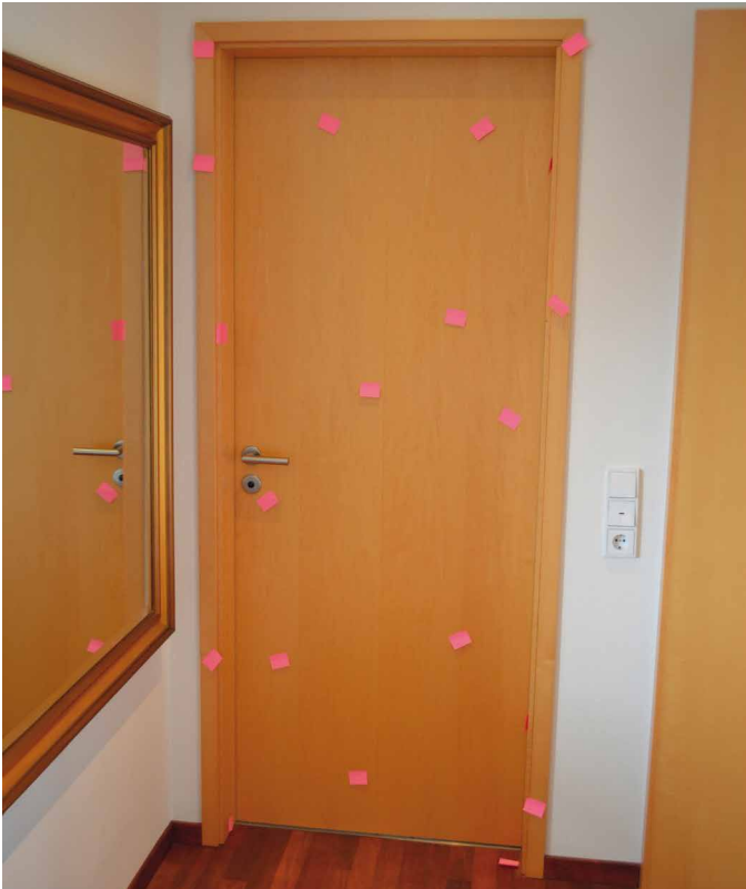
Eine solche Abnahmesituation ist nach den Regelwerken nicht zulässig. Die Markierungen sind vor der Prüfung zu entfernen
