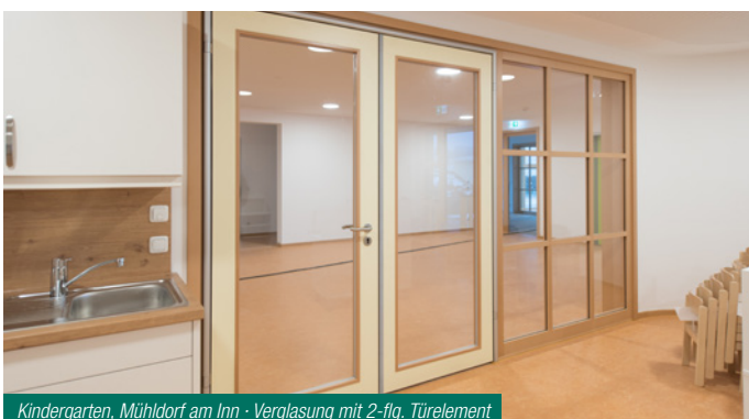
Kindergarten, Mühldorf am Inn · Verglasung mit 2-flg. Türelement
