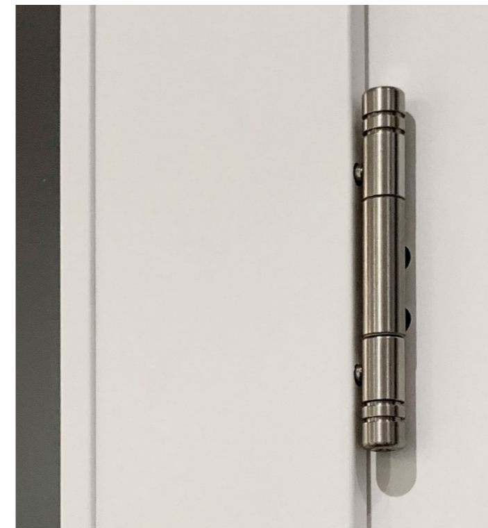
Ein 3-teiliges Band besteht aus drei Teilen. Der obere und untere Teil des Bandes mit jeweils nur einem Gewinde ist an die Tür verschraubt, das mittlere Teil mit zwei Schraub-Gewinden gehört an die Zarge. Verbunden werden diese Teile durch einen Stift.
